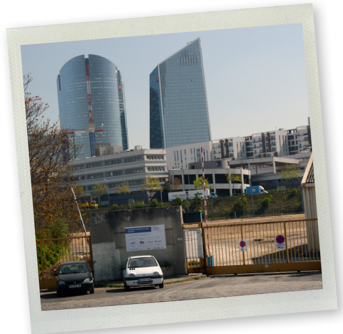
Site de la future gare Nanterre-la-Folie
