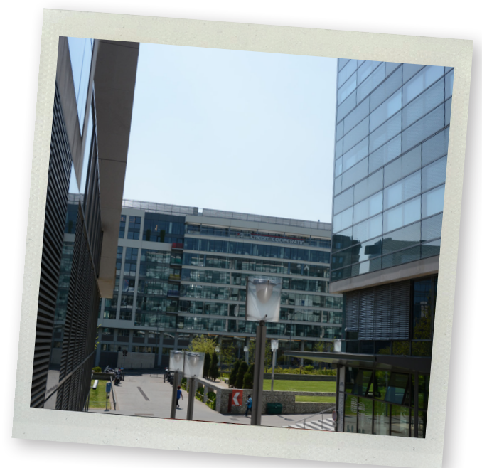
Entreprises des Terrasses
