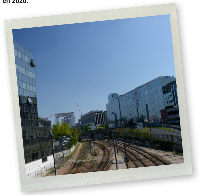
Voies SNCF séparant Les Groues des Terrasses de Nanterre
