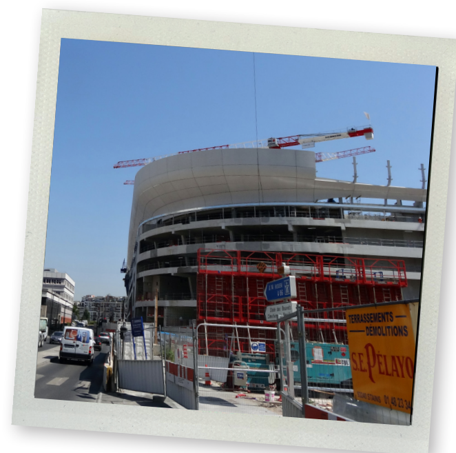
Travaux du stade Arena
