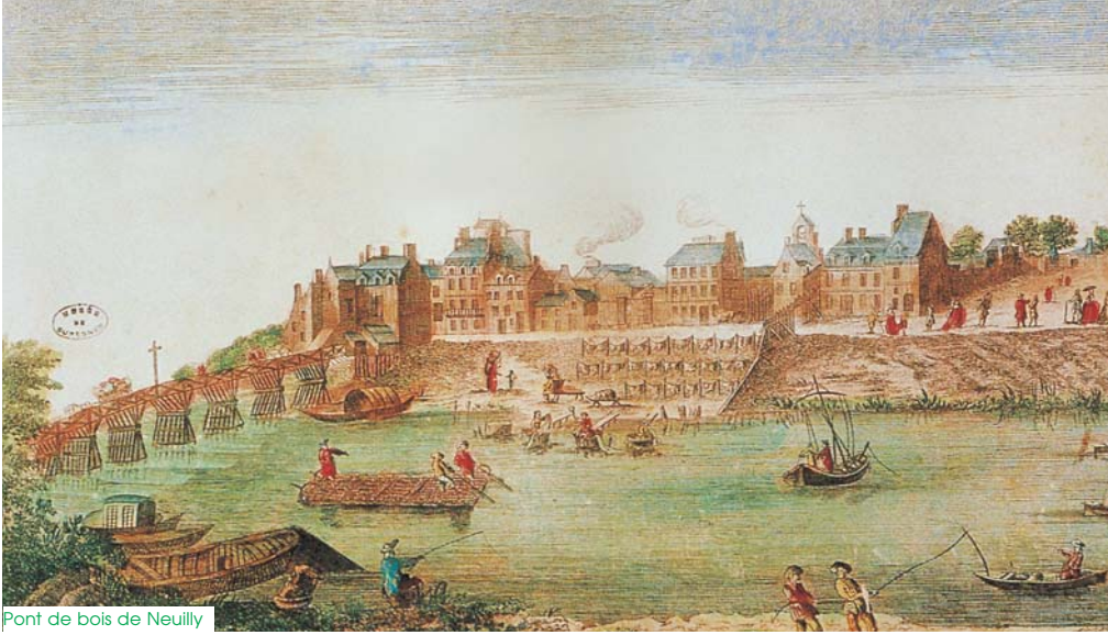
Pont de bois de Neuilly
