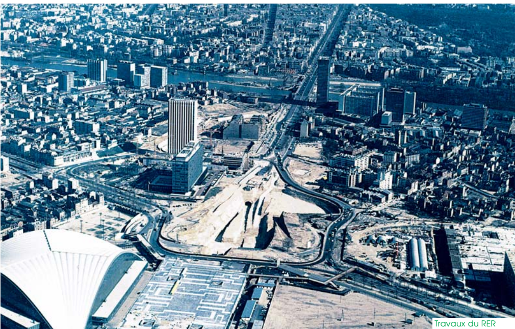
Travaux du RER
