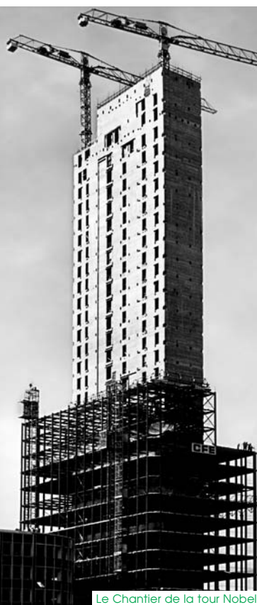
Le Chantier de la tour Nobel
