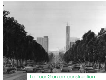
La Tour Gan en construction
